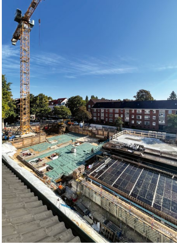
Großbaustelle unweit des Barmbeker Bahnhofes: Im ersten Bauabschnitt entstehen 57 öffentlich geförderte Wohnungen.
