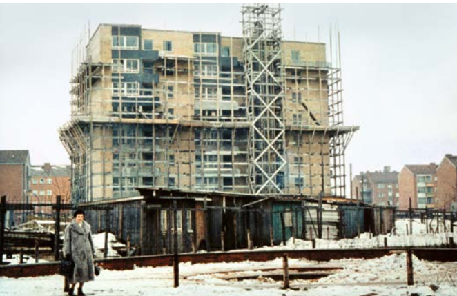
Letzte Bauphase am Wandsbeker Schützenhof.
