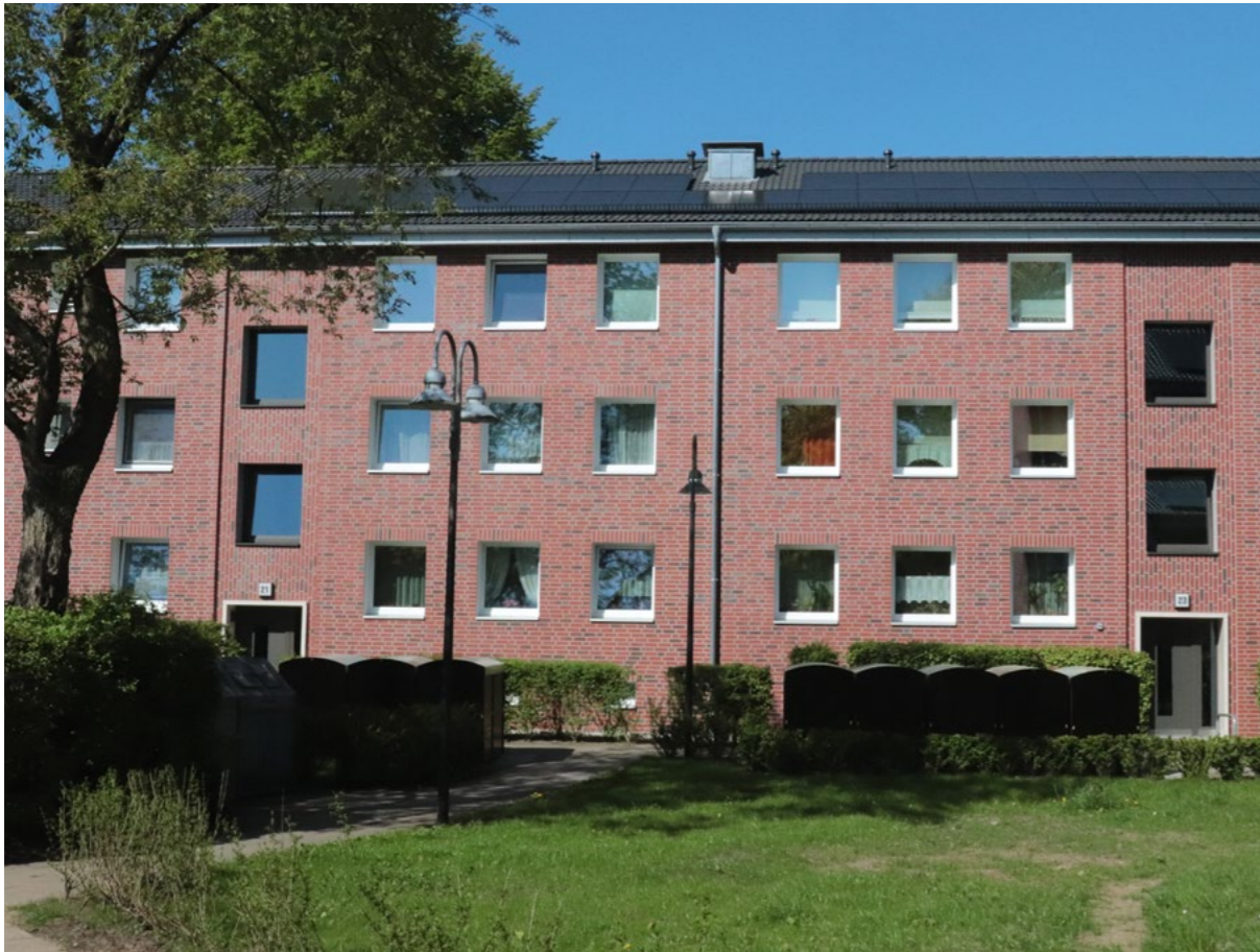
Start der energetischen Sanierung im Quartier Moorgrund: 48 Wohnungen werden modernisiert – Ziel: 60 Prozent weniger Energieverbrauch.
