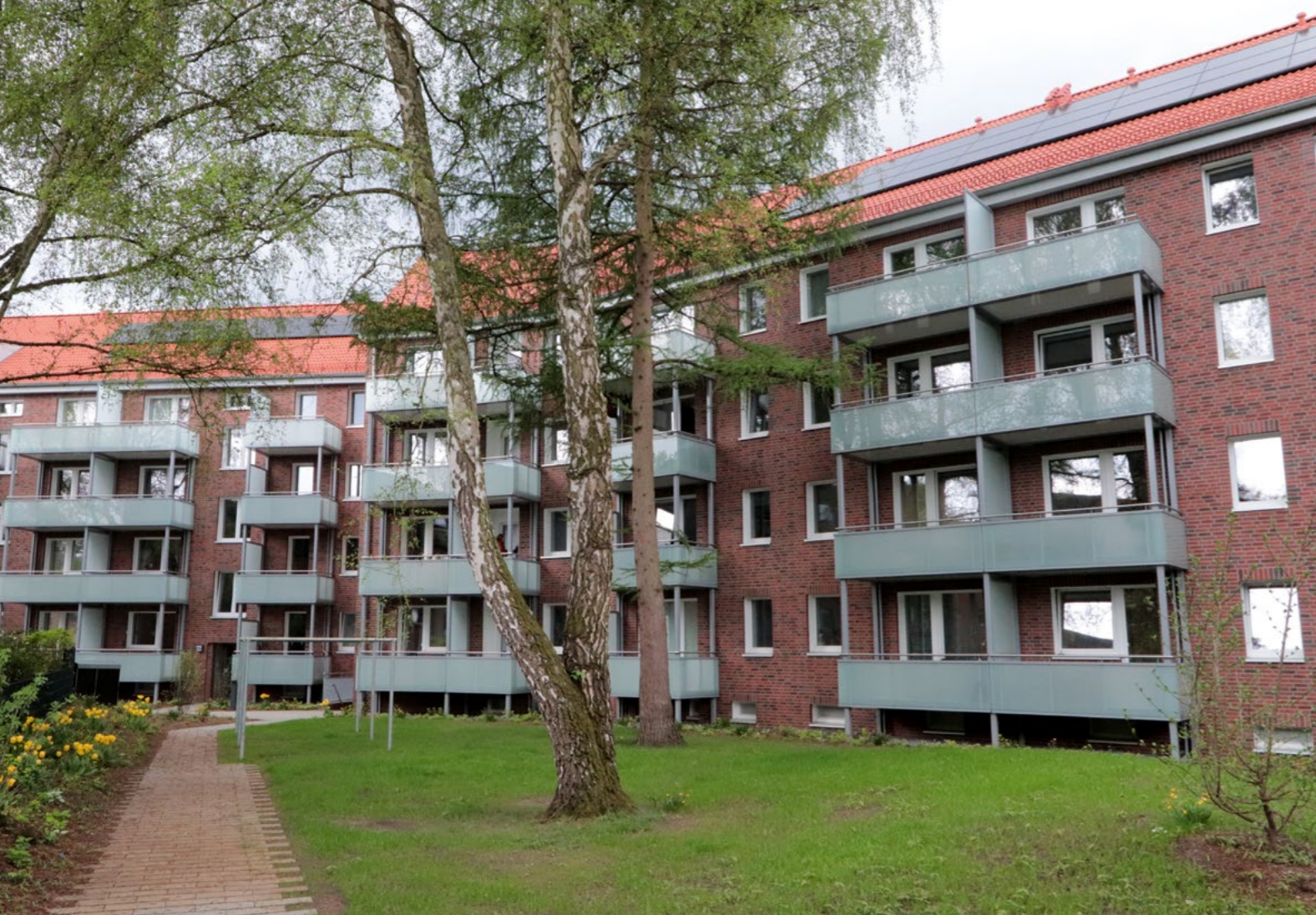
Energetische Modernisierung 2024: 41 Wohnungen mit neuer gedämmter Gebäudehülle, neuen Balkonen, Fenstern und Photovoltaik.
