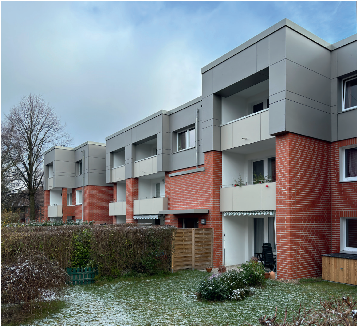
▲ Wolliner Straße: Hier wurden insgesamt 93 Wohnungen energetisch modernisiert.
